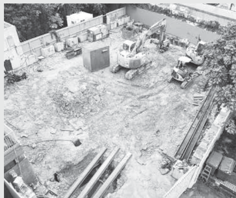
新教研大樓工地上的地基工程
